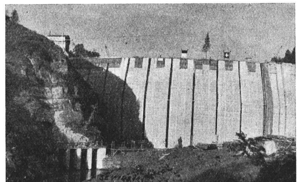
Fig. 1 Le barrage de Rossens, vu d'amont le 21 novembre 1947
