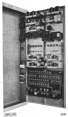
Fig. 7 Apparateschrank der Fernwirkanlage in der Zentrale Waltensburg, geöffnet Grundsätzlich ähnliche Anordnung wie Fig. 5
