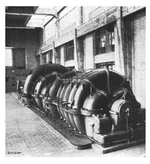
Fig. 4 Turbokompressor der Kochstation
