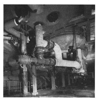
Fig. 6 Saftverbindungs- und Kondensatsammelleitungen unter den Verdampfern
