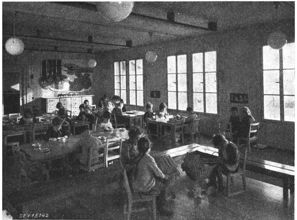
Fig. 1 Schulstube des Kindergartens in Riehen (BS) An der Decke sichtbar drei der insgesamt vier Strahlungsheizkörper
