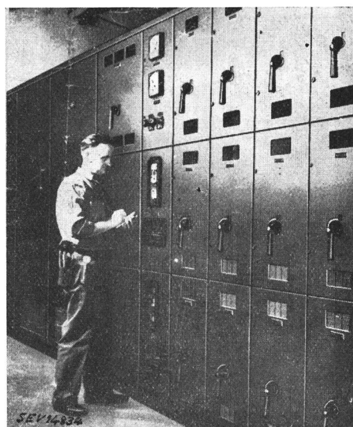
Fig. 10 Verteilanlage für Innenraum, aus vorgefabrizierten Schalteinheiten zusammengesetzt
