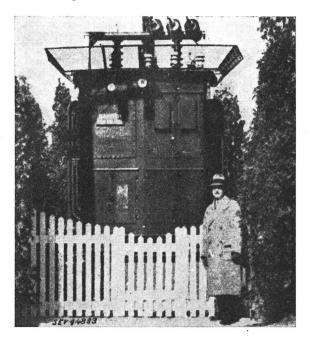
Fig. 9 Einheits-Transformatorenstation für Verteilnetze
