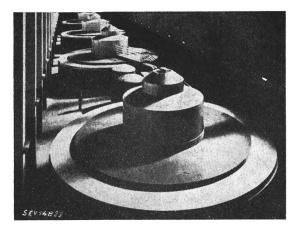
Fig. 4 Innenansicht des Kraftwerkes «Pickwick-Landing» der Tennessee Valley Authority (6 imes 36 000 kVA)
