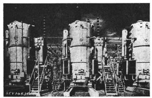
Fig. 6 Transformatorengruppe von 3  $\times$  50 000 kVA 220/66 kV mit Stufenschaltern
