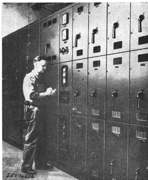
Fig. 10 Verteilanlage für Innenraum, aus vorgefabrizierten Schalteinheiten zusammengesetzt
