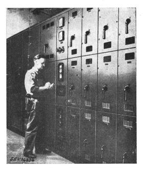
Fig. 10 Verteilanlage für Innenraum, aus vorfabrizierten Schalteinheiten zusammengesetzt
