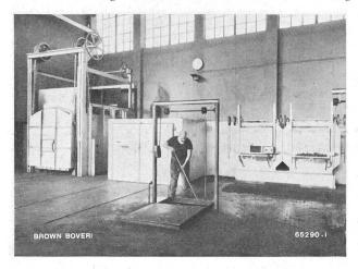
Fig. 5 Moderne elektrische Glüh- und Härteofenanlage
