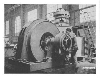
Drehstrom-Generator 530 kVA, 2400 V, 500 U./min, in vollständig geschweisster Konstruktion bestimmt für das Kraftwerk der Compagnie textile Santa Basilissa (Brasilien)
