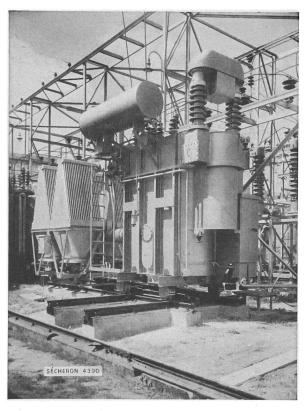
Fig. 3 Drehstrom-Transformator 6000 kVA mit Stufenschalter unter
