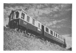
Fig. 2 Automotrice FMA L'automotrice est munie de patins pour le rail de contact (on en voit les plaques de protection le long du bogie) et d'un pantographe pour la ligne aérienne.
