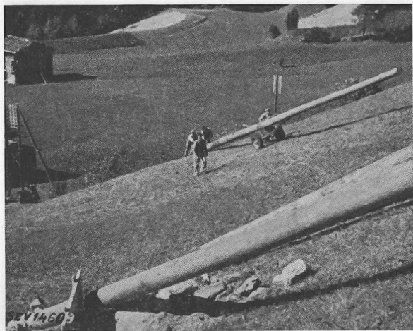
Fig. 12 Stangentransport mit Wagen und Winde
