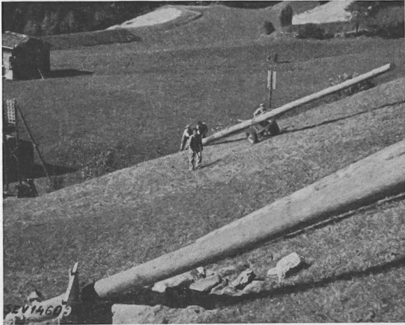
Fig. 12 Stangentransport mit Wagen und Winde
