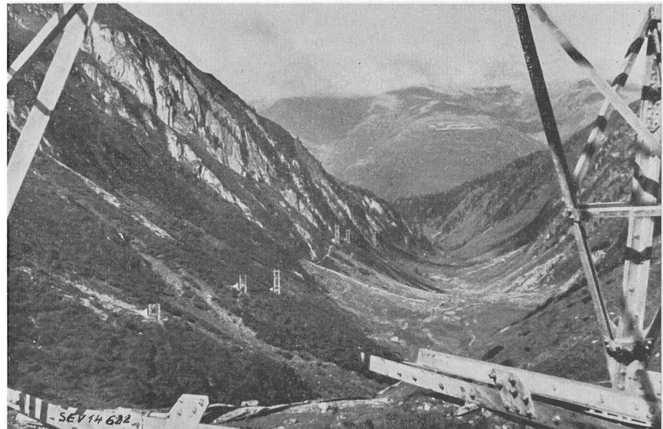
Fig. 24 Leitungstrasse im Aegidental von oberhalb Ladstäg (Mast 192)
