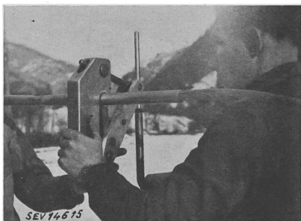
Fig. 17 Verstärkung der Alutherm-Schweißstellen in den Spannweiten mit Rohrverbinder Einkerben mit Handpresse
