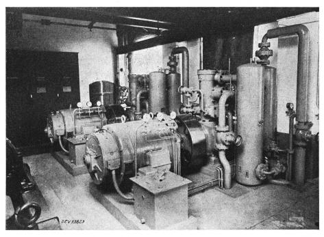
Fig. 13. Kompressorengruppen der Wärmepumpenanlage
