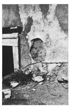
Fig. 15. Effet d'explosion d'un courant de foudre dans le mur du bâtiment de mesures du Monte San Salvatore, le 22 mai 1945
