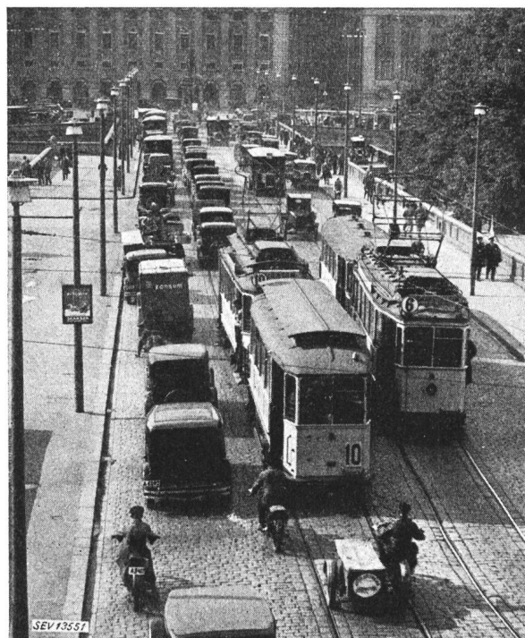
Fig. 1. Verkehr im Jahre 1931 auf der Norrbrö, der ältesten und wichtigsten Brücke im Zentrum Stockholms
