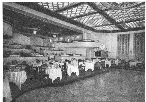
Fig. 2. «Embassy» nach dem Umbau; Blick gegen Empore
