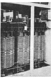
Ansicht des Kern- und Wicklungsaufbaues eines luftgekühlten Trockentransformators
