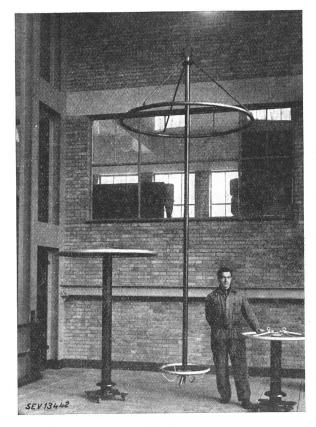
Fig. 2. Spannungsteiler der KEMA für 2000, 1000 und 300 kV
