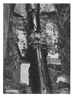
Fig. 15 Permanente Meßstelle zur dauernden Kontrolle der elektrisch überbrückten Schraubmuffen-Verbindung an im Betrieb stehenden Wasserleitungen
