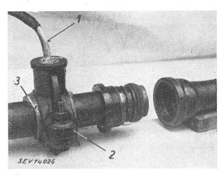
Anschluss des Erdleitungskabels an die Wasserleitung und Schraubmuffe mit Stromüberbrücker
