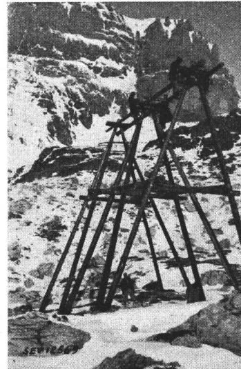
Fig. 9. Bockmast in Montage
