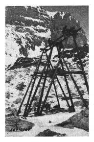
Fig. 9. Bockmast in Montage
