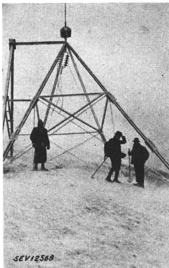
Fig. 8. Umgebautes Spezialtragwerk auf der oberen Schmiede
