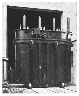
Fig. 2. Transformator beim Transport zum Aufstellungsort  $16\ 500\ \mathrm{kVA};\ 8.8/150\ \mathrm{kV};\ 50\ \mathrm{Hz}.$
