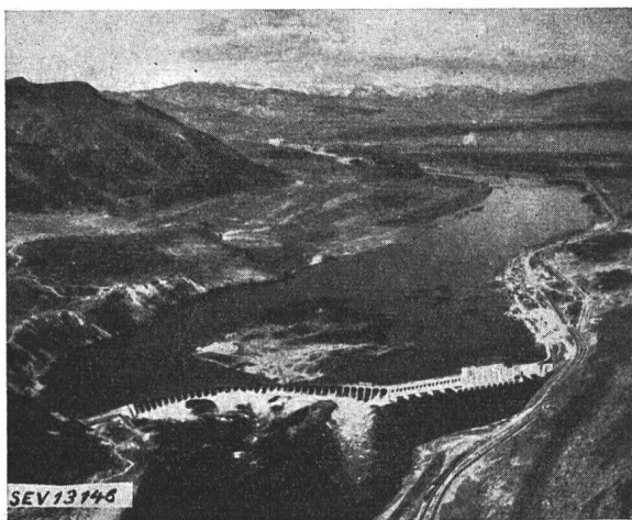
Fig. 9. Rock-Island-Kraftwerk [4 (später 10) × 16 667 kVA]
