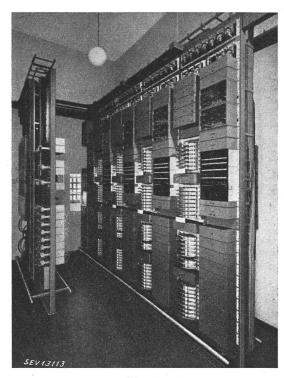
Fig. 13. Hausautomat für 600 Anschlüsse, zusammengebaut mit dem Schrank Fig. 12
