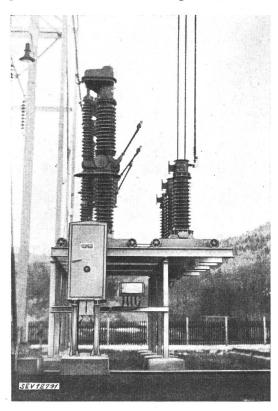
Fig. 9. Ring-Kabelwandler, angebaut an 150-kV-Oelstrahlschalter mit Trenner
