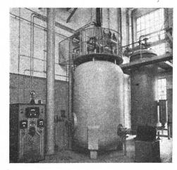
Fig. 1. Sulzer-Elektro-Heisswasserkessel 5000 kW, 6 kV, 12 kg/cm<sup>2</sup> Betriebsdruck, in einem Fernheizwerk
