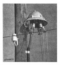
Fig. 1. Stangen-Endverschluss, Modell AM
