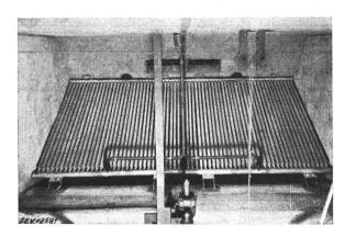
Fig. 3. Verdampferelement im Abluftschacht
