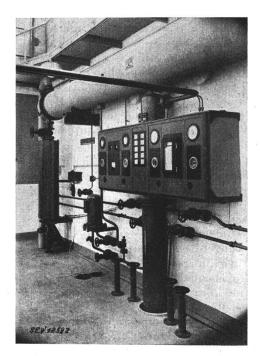
Fig. 4. Apparate der Wärmepumpe
