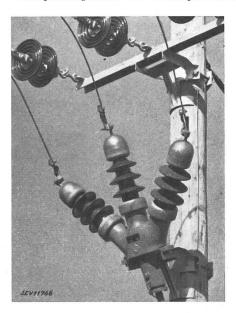
Fig. 2. Hochspannungs-Kabelendverschluss AES für Freiluftmontage
