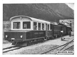
Fig. 1. Sécheron-Akkumulatoren-Triebwagen der Kraftwerke Oberhasli ¹) mit Traktionsbatterie Leclanché
