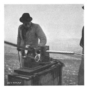
Fig. 40. Pressen einer Aluminiummuffe
