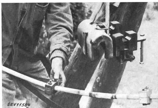
Fig. 7. Fertige Schweissung auf dem Mast Spannapparat abgenommen
