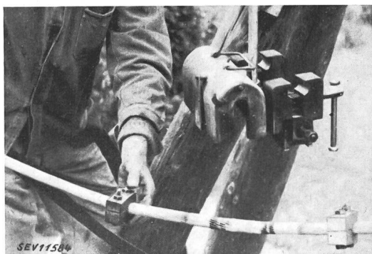
Fig. 7. Fertige Schweissung auf dem Mast Spannapparat abgenommen
