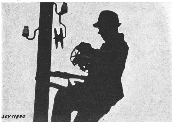
Fig. 5. Unzweckmässige Auslegerrolle Rollendurchmesser zu klein
