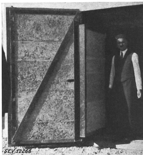
Fig. 8. Eingang in die schalldichte Umschalung des Transformators Fig. 7 Das Bild gibt einen Begriff von der Stärke der Wandkonstruktion.
