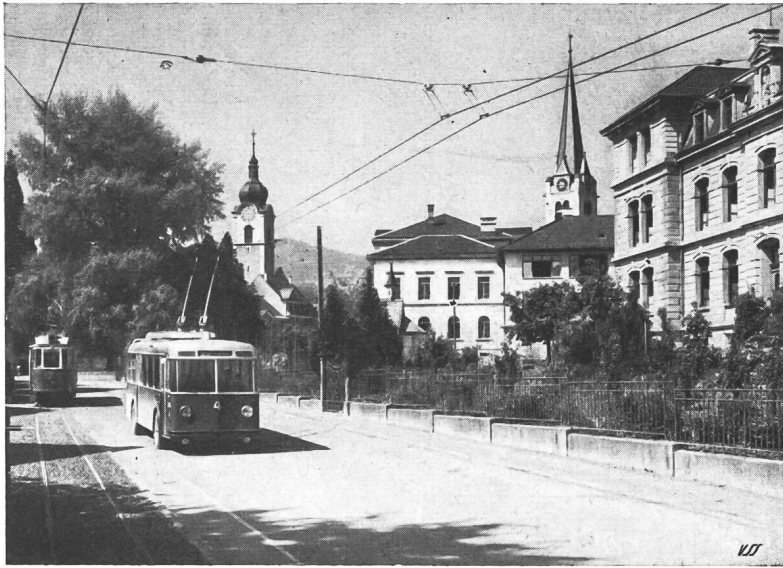
Fig. 1. Gemeinschaftsstrecke Bahn-Trolleybus in Altstätten
