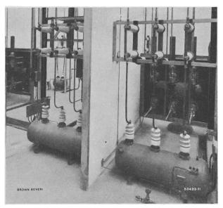
Fig. 4. Oellose Schaltanlage mit Druckluftspannungswandlern für 32 000/100 V
