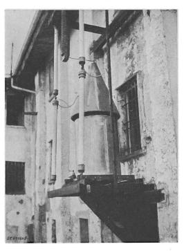
Fig. 4. Meßshunt für den Blitzstrom Unter den Blechhauben als Regenschirmen befinden sich die Shunte für 3 Strombereiche. Oben Spule zur Messung der Stromsteilheit, mit 4 induktionsfreien Rohrwiderständen für 2 Messbereiche.
