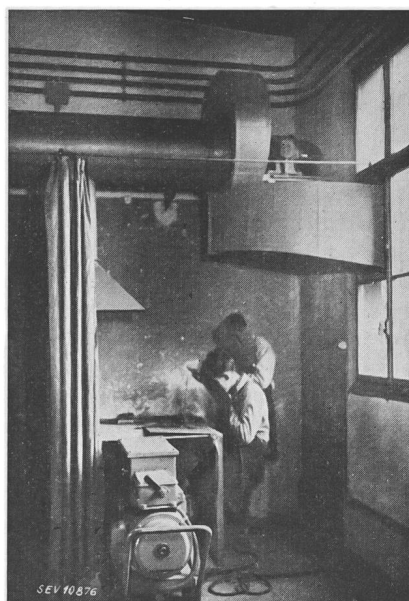
Fig. 5. Elektrisch geschweisste Ventilationsanlage und Blick in eine Schweisskoje
