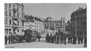
Fig. 6. Motorwagen der elektrischen Strassenbahn Zürich aus dem Jahre 1894 auf dem Bellevueplatz (Gleichstrom 500 V)
