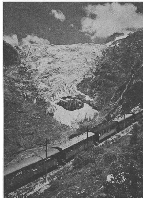
Fig. 40. Zug der Furka-Oberalp-Bahn beim Rhonegletscher (Einphasen-Wechselstrom 11 000 V, 16\frac{2}{3} Per./s)
