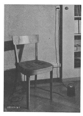
Fig. 6. Stuhl mit Kontaktkissen und Stufenschalter
