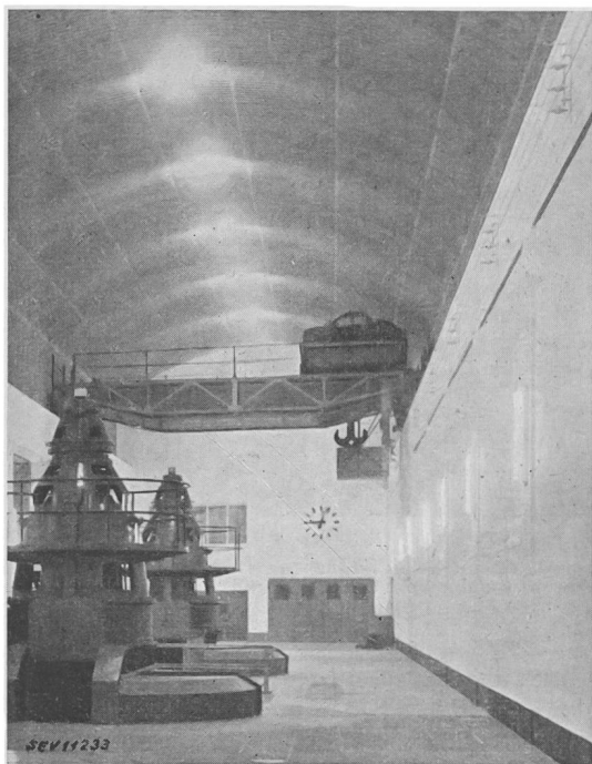
Fig. 3. Maschinensaal mit 120-t-Laufkran und direkter Deckenbeleuchtung
