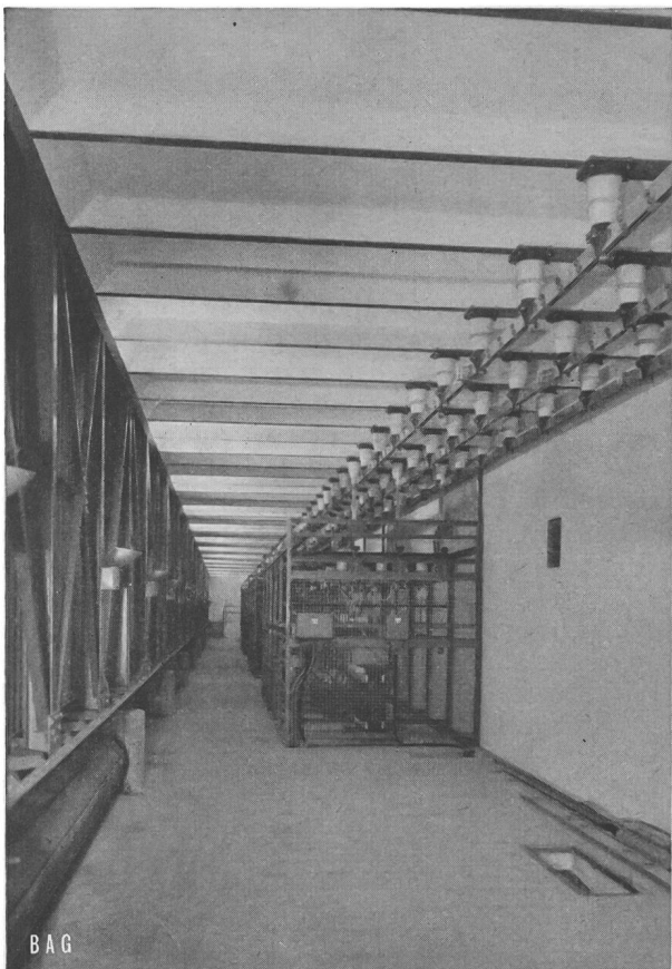
Fig. 18. 13-kV-Raum mit indirekter Beleuchtung
