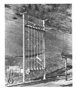
Fig. 2. Schaltposten einer FO-Station.
