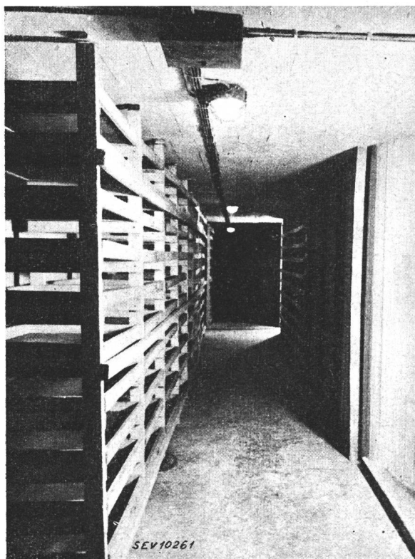
Fig. 1. Dörrhurden im Generatorabluftkanal.
