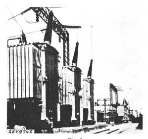
Fig. 6. 287/132-kV-Autotransformatoren.  $3\times80~000~\mathrm{kVA}$
