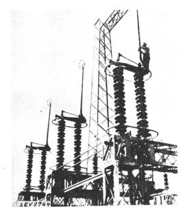
Fig. 5. 287-kV-Trenner.
