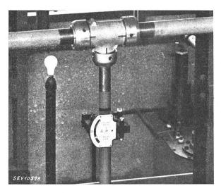
Fig. 4. Schienen-Amperemeter, eingebaut in einem 50-kV-Sammelschienensystem
