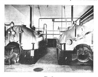
Fig. 2. Kombinierte Elektrokessel mit Kohlenfeuerung
