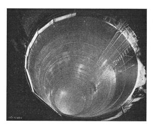
Fig. 2. Blick in den Vertikalschacht des Wasserschlosses
