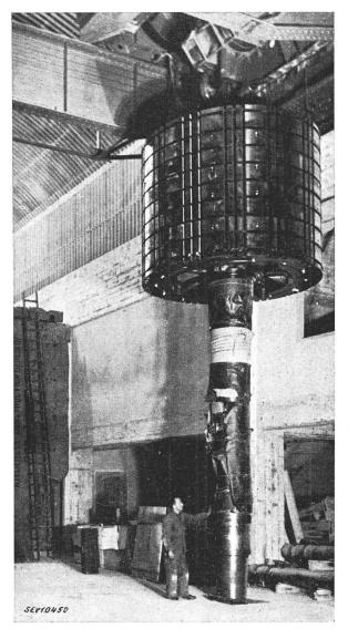
Fig. 13. Rotor mit Welle am Kran (Maschinenfabrik Oerlikon).
