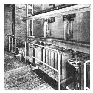
Fig. 16. Wasserwiderstand für 13 kV, 41 000 kW
