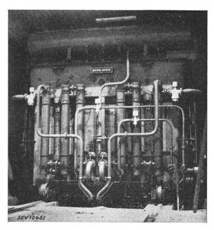
Fig. 15. Transformator in der Zelle (Brown Boveri).
