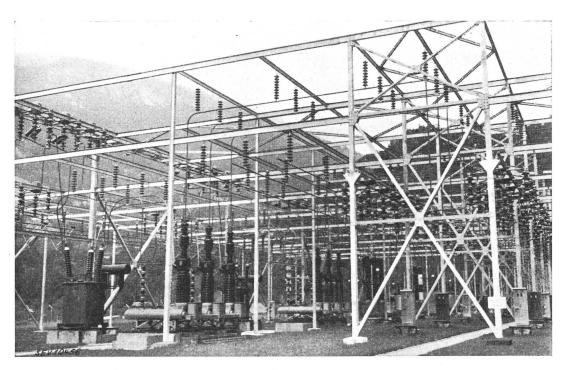
Fig. 20. Blick in die 150-kV-Schaltanlage
