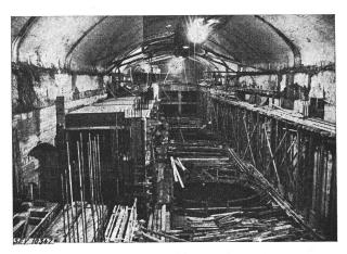
Fig. 9. Maschinenkaverne Innertkirchen im Bau.
