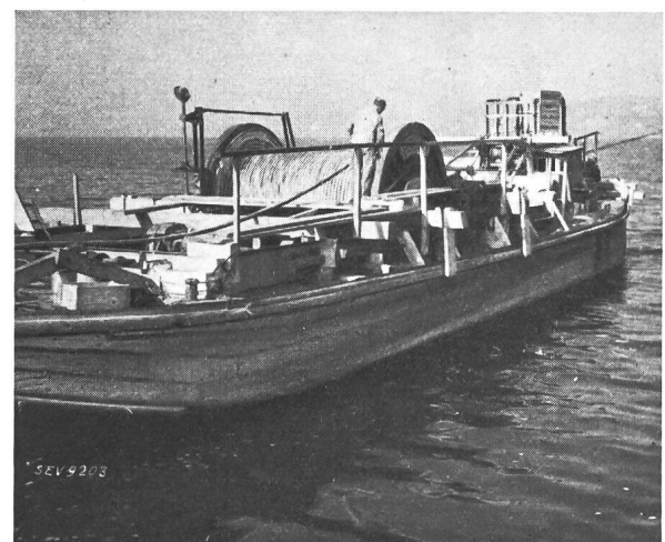
Fig. 6. Aufwickeln des Kabels auf dem Schiff.
