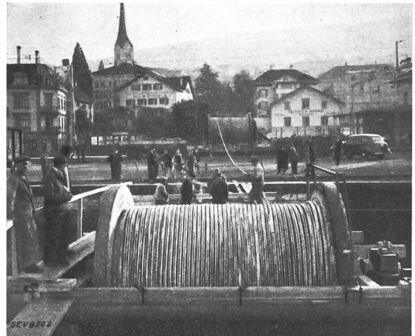
Fig. 5. Umladung des Kabels vom Bahnwagen auf das Schiff
