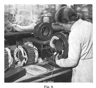
Einlegen der auf Schablonen vorgeformten Spulen in die Nuten des Blechkörpers ausserhalb des Gehäuses.
