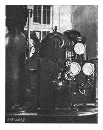
Fig. 7. Löntschwerk. Drehzahl-Regulator Turbine 8.
