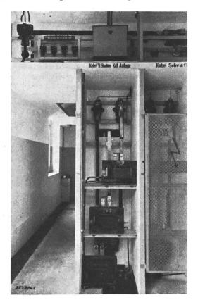
Fig. 4. Emissions-Transformatoren 2000 V.
