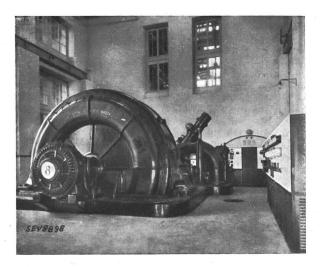
Fig. 6. Löntschwerk, 12 000-kVA-Drehstromgenerator 8.
