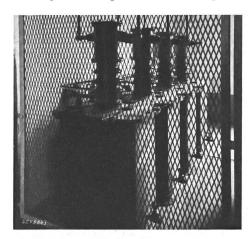
Fig. 5. Emissions-Transformatoren 16 000 V.
