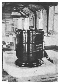
Fig. 7. Transformator der MFO, 150 kVA.
