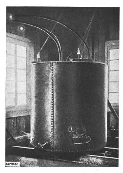
Fig. 6. Transformator der AEG, 150 kVA.
