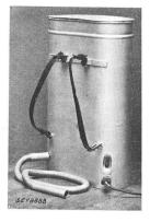
Beschreibung: Apparat gemäss Abbildung für die Herstellung von Fischeritbelägen an Wänden. Unten eingebautes Gebläse bläst Korkgries durch den flexiblen Metallschlauch. Gebläse durch Einphasen-Seriemotor angetrieben. Schalter und Apparatestecker eingebaut.
