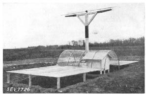
Fig. 5. Horizontaler Dipol für Vor- und Hauptsignal mit Gegengewicht und Senderhäuschen.
