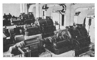
Fig. 1. Wärmepumpen in Bauart als Turboverdichter für je ca 10 000 kg Dampfförderung, aufgestellt in einer von Escher Wyss gelieferten Eindampfungsanlage.
