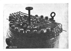
Fig. 4. Oelheizkessel (Anschlüsse).
