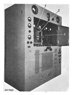
Fig. 3. 5-kW-Stufe. 1 Spulen, 2 Kondensator, 3 Röhrenhalter.
