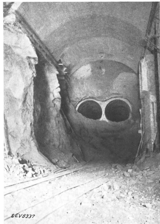
Fig. 2. Hinterer Teil des Maschinenraumes. Die beiden Röhren an der hintern Abschlusswand sind die beiden Brennstofftankstollen von 3 m Durchmesser und je 22,5 m Länge.
